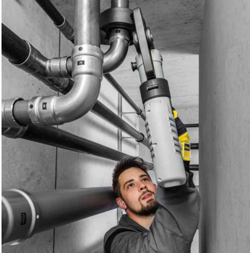
Dzięki systemowi Megapress bezpieczna technika zaprasowywania na zimno jest dostępna również w przypadku rur ze stali grubościenniej.
