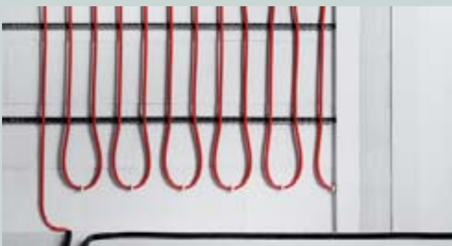
Fonterra Side 12 Clip System ścienny, na mokro, moż- liwe chłodzenie
