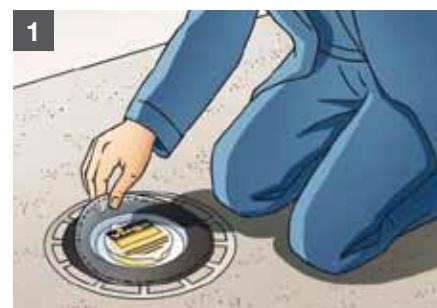
Jeden z wpustów podłogowych DN 50 zastosowanych na pływalni.
