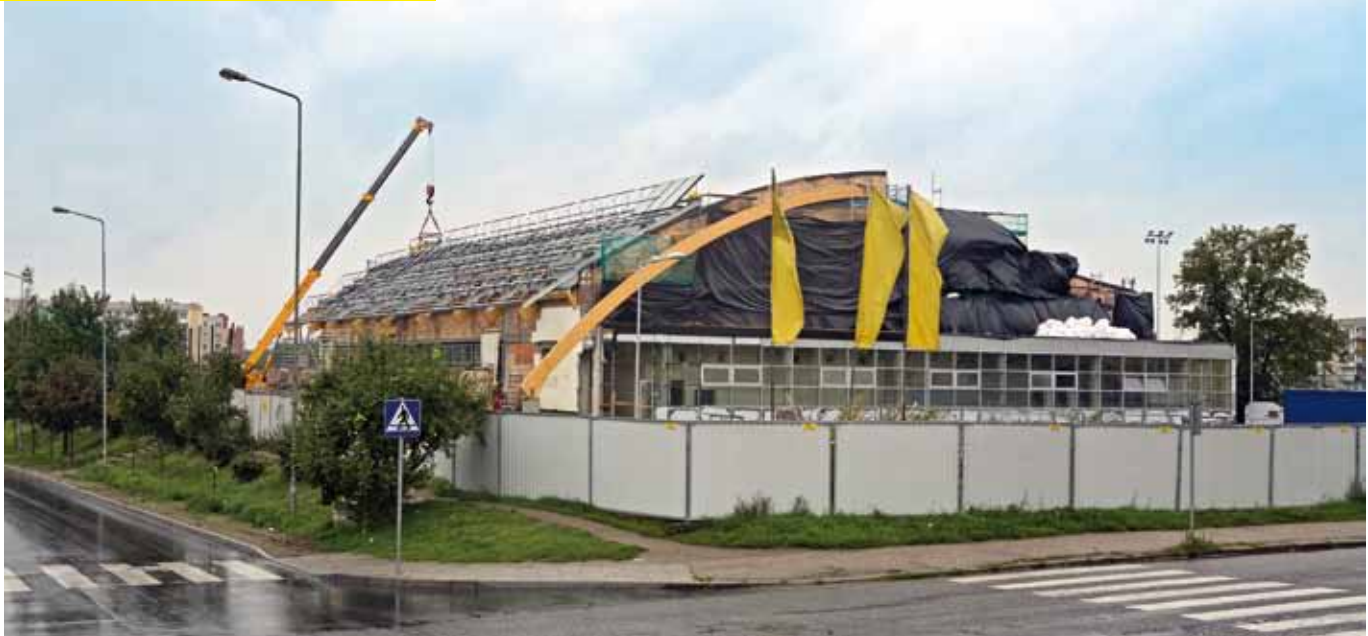
Zakończenie budowy pływalni w Żaganiu planowane jest na wiosnę 2011 roku.
