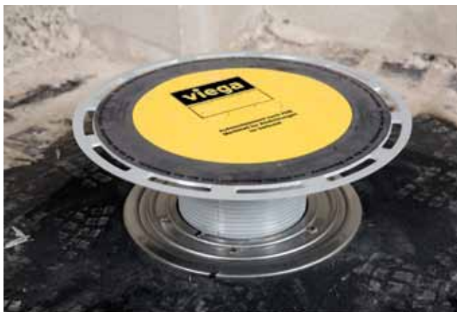
Jeden z wpustów podłogowych DN 50 zastosowanych na pływalni.
