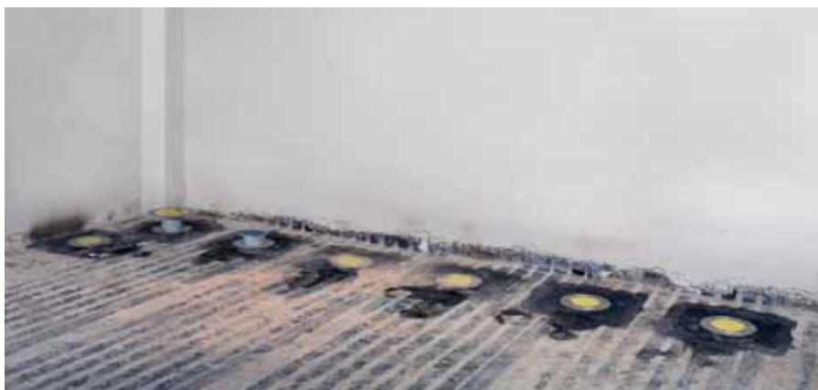
Wpusty podłogowe w łazience, na wczesnym etapie montażu.
