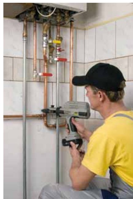
Zaprasowywanie złąček przy użyciu zaciskarek Viega trwa zaledwie kilka sekund.
