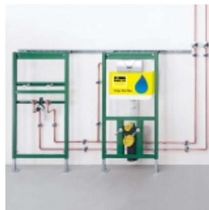
Instalacje sanitarne łatwo wykonane z zastosowaniem złączy firmy Viega.
