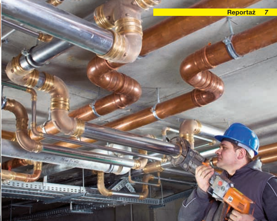
Instalator podczas zaprasowywania złączek z brązu Sanpress.
