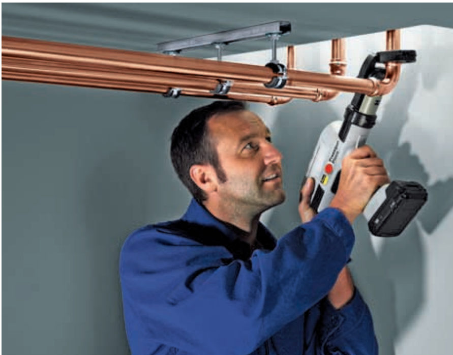
Dzięki ergonomicznym zaciskarkom nie ma problemu z zaprasowywaniem złączek nawet w trudno dostępnych miejscach.
