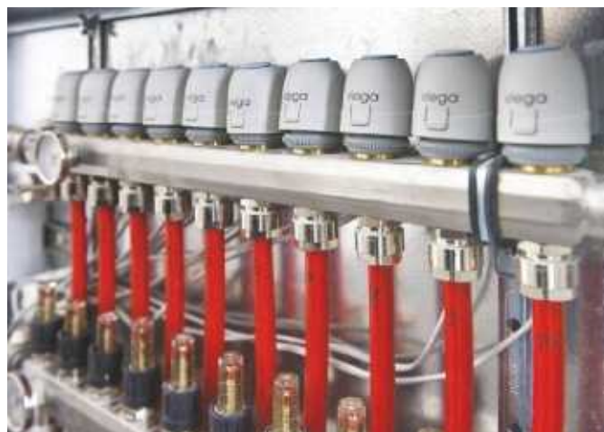
We wszystkich budynkach zainstalowano kompletny system ogrzewania podłogowego firmy Viega, łącznie z rozdzielaczami.
