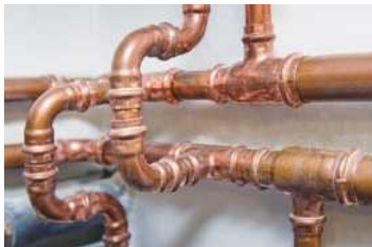
Instalacja grzewcza: miedziane złączenia Profipress.
