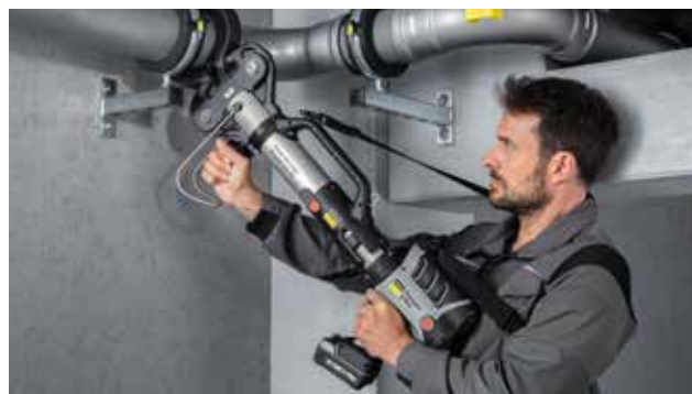
Umożliwia zaprasowywanie grubościennej stali do 4 cali: Pressgun-Press Booster.
