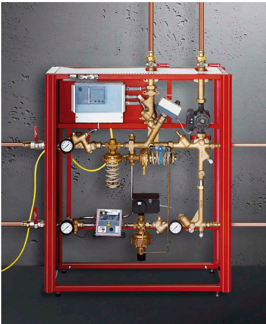
Również do wysokich temperatur w sieciach ciepłowniczych i niskociśnieniowych instalacjach parowych: Viega Profipress S.
