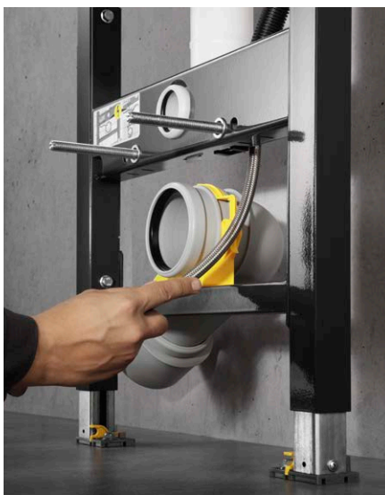
Doprowadzenie wody do WC z funkcją mycia: łatwy montaż w rurce osłonowej
